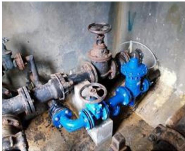
Réservoir de Bouyon (ex-régie) – Pose d'un robinet altimétrique Lauram permettant de piloter le débit
